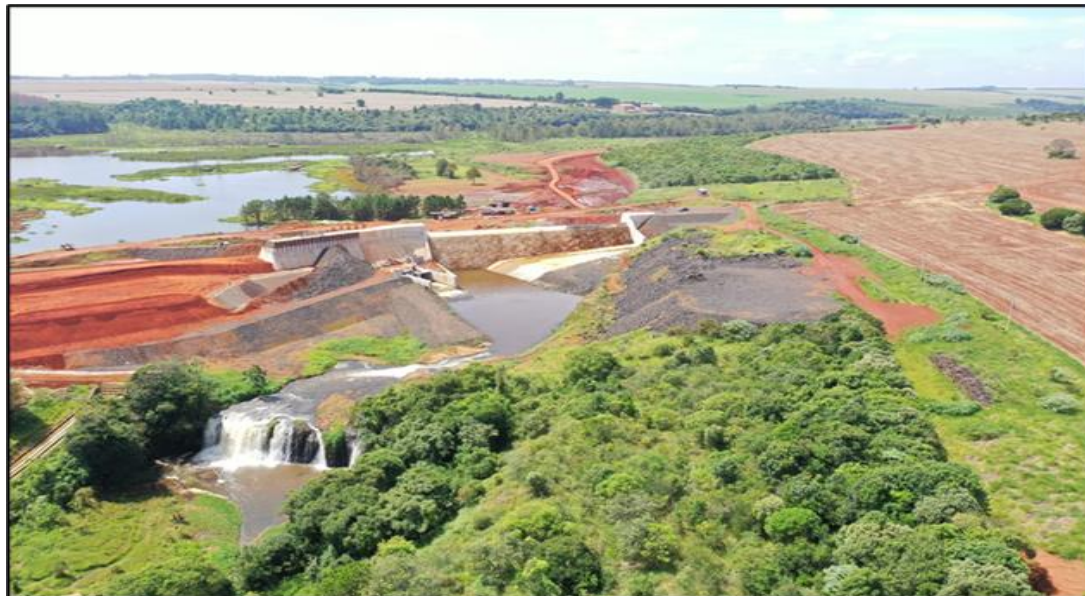
Figura 4 - Vista aérea da Barragem do Rio Pardo no início das obras
